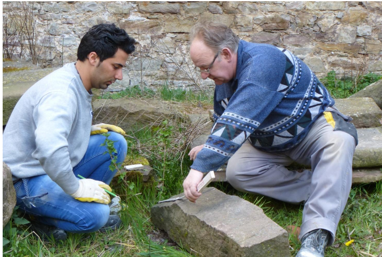
Integrativer Ort BauDENKMAL als innovativer Arbeitsort - Denkmalgerechte, energetische, Ressourcen
